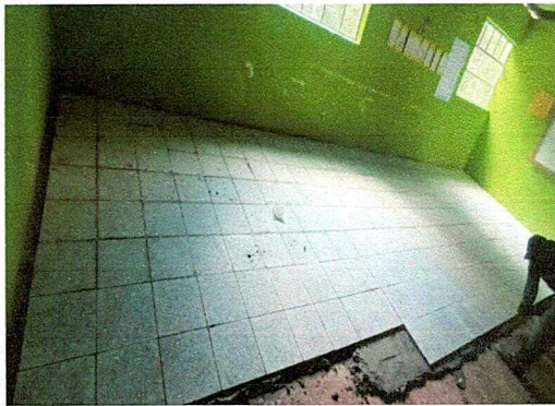
Foto 3: Colocación de piso
