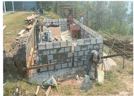
Foto 4: Colocación de blok en la cocina
