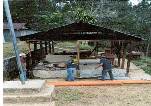
Foto 2: Eliminación de madera de la cocina
